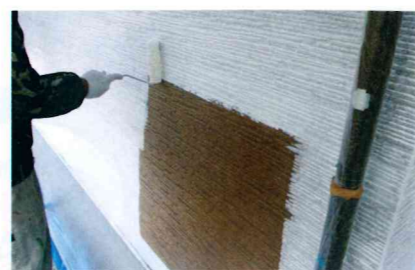
◀VEシステムズの下地は2回塗りが基本。「見えない部分だからこそ手を抜かれません!」
